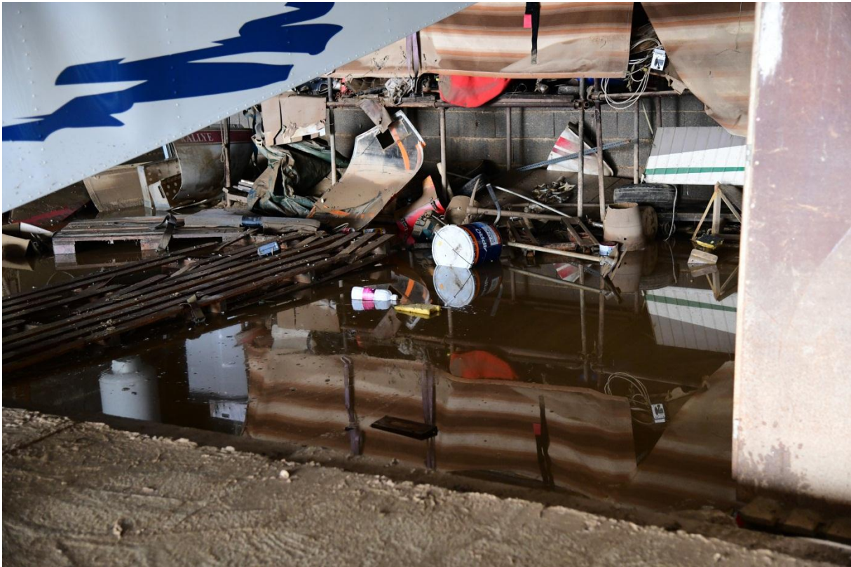
Le hangar dévasté
